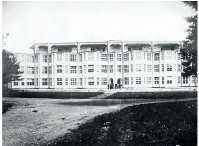
Sanatorium w Rabsztynie- strona południowa. 1938 r. (Foto: Arch. Sanatorium)
